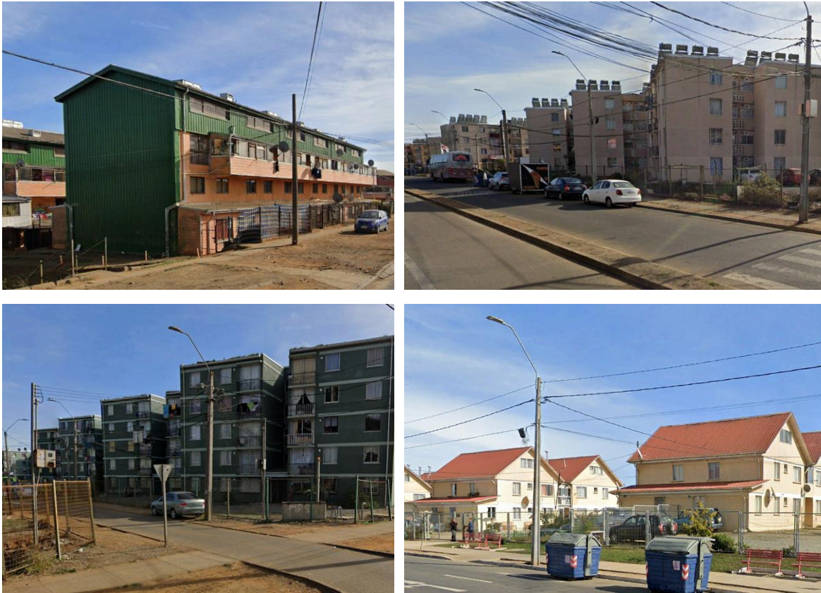
FIGURA 23.6-5: ZONAS HOMOGÉNEAS TRAMO 3 VIVIENDAS COLECTIVAS EN ALTURA.
